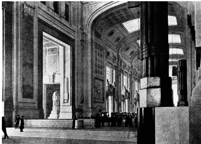
5.16 and 5.17 Ulisse Stacchini, Stazione Centrale Viaggiatori, Milan, 1912–31
